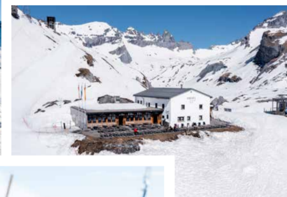
Segneshütte vor dem Umbau Segneshütte before the renovation
